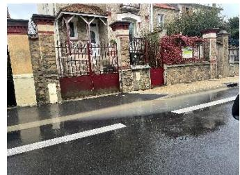
Par ailleurs, des contrepentes sur les trottoirs provoquent des retenues d'eau et donc des accumulations de saleté sur le revêtement en béton lavé.
