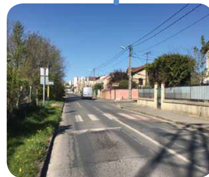
LES ARRÊTS DE BUS NE SONT PAS AUX NORMES D'ACCESSIBILITÉ
