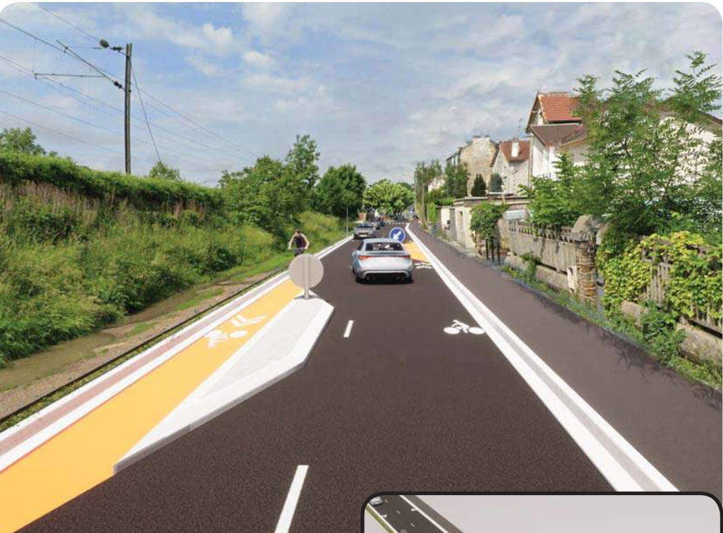
RÉDUCTION DE LA VITESSE AVEC DES CHICANES AMÉNAGÉES EN GARDANT LA CONTINUITÉ DE LA BANDE CYCLABLE
