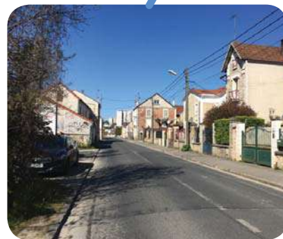
LE TROTTOIR CÔTÉ SUD N'EST PAS AU GABARIT PMR
