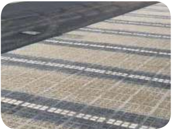
3 STATIONNEMENT PERMÉABLE (TYPE EVERGREEN OU PAVÉS DRAINANTS)
