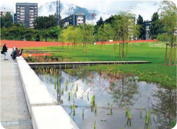
7 BASSIN / NOUE D'AGRÈMENT et de gestion intégrée des eaux pluviales
